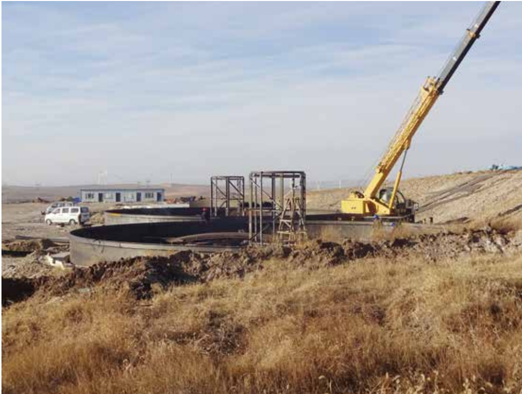
▲ Baufortschritt der ersten Ausbaustufe einer geplanten Biogasanlage
