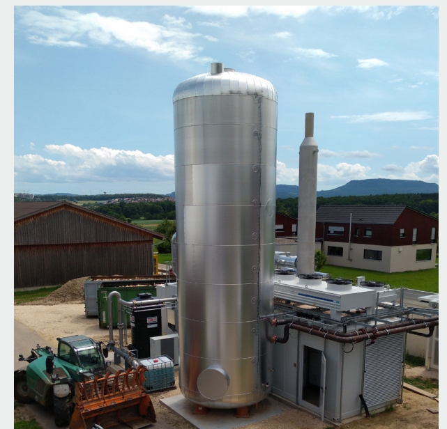
BHKW-Container mit Pufferspeicher
