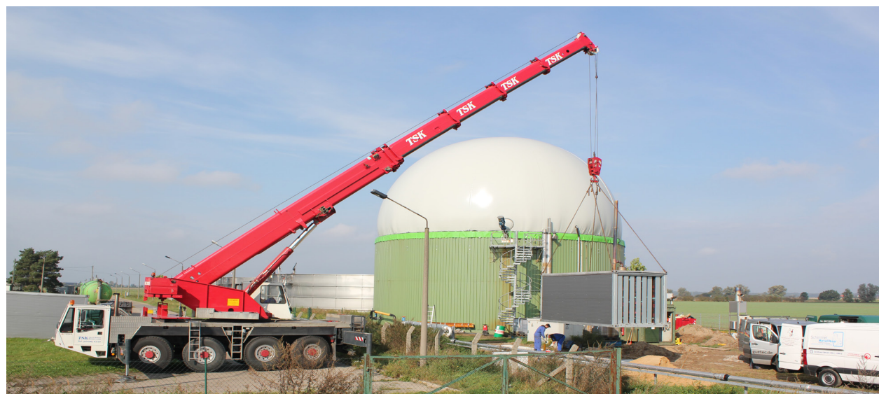
Flexibilisierung einer BGA: ein neues Foliengaslager ist bereits installiert, das zusätzliche BHKW befindet sich im Aufbau
