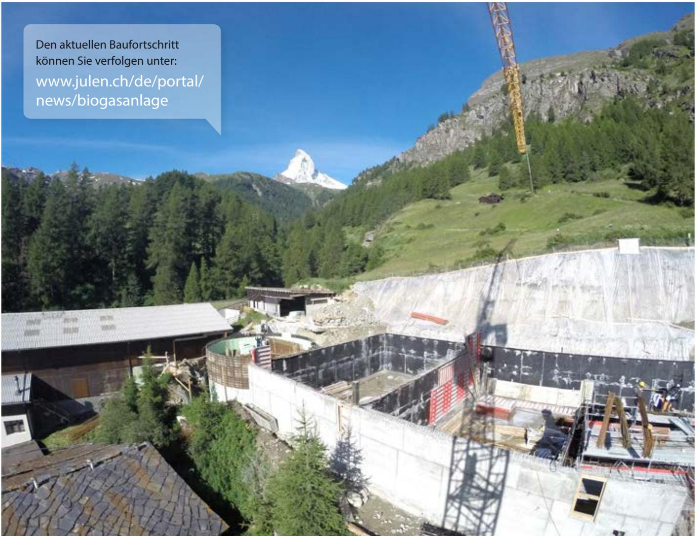
▲ Die Biogasanlage wird unterirdisch inklusive Fermenter, Nachgärer sowie Gas- und Zwischenlager installiert. © Familie Julen
