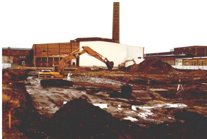
Massenumlagerungsarbeiten zu Beginn der Sanierungsmaßnahme
