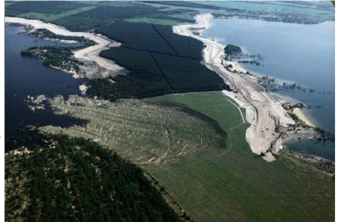
Abb. 3: Setzungsfleßen (ca. 4,5 Mio. m 3 ) Koschendam
