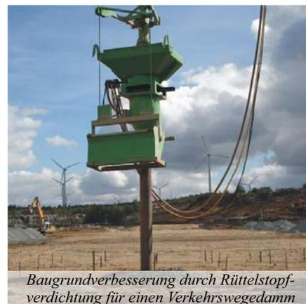
Baugrundverbesserung durch Rüttelstopfverdichtung für einen Verkehrswegedamm
