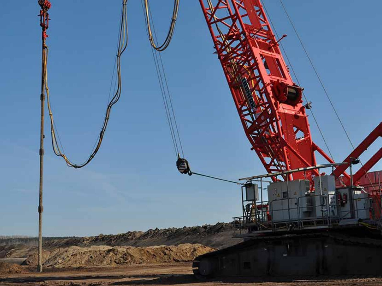
▲ Aufgelockerte Böden wurden im ehemaligen Tagebau mit dem Rütteldruckverfahren verdichtet
