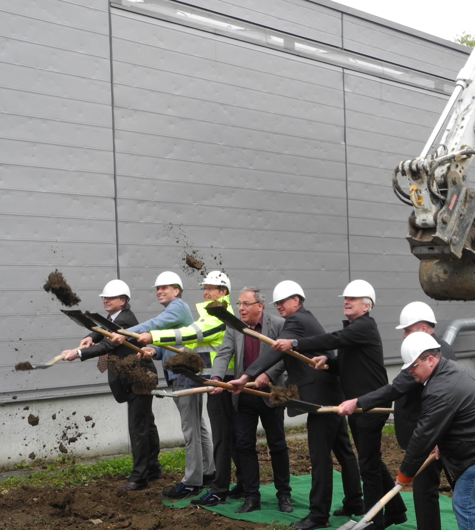
Spatenstich für Krematoriumserweiterung der Stadt Reutlingen
