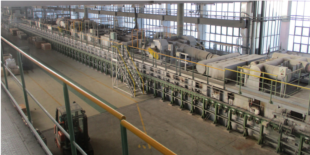
▲ Die Wartung und Reparatur des Rollenköhlens hat insgesamt 40 Tage in Anspruch genommen.
