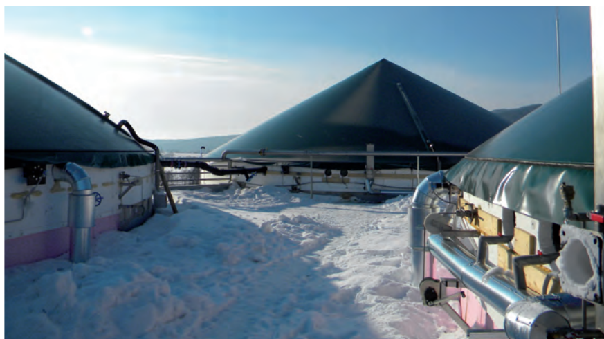
▲ Blick über die Dächer der Biogasanlage Hertník
