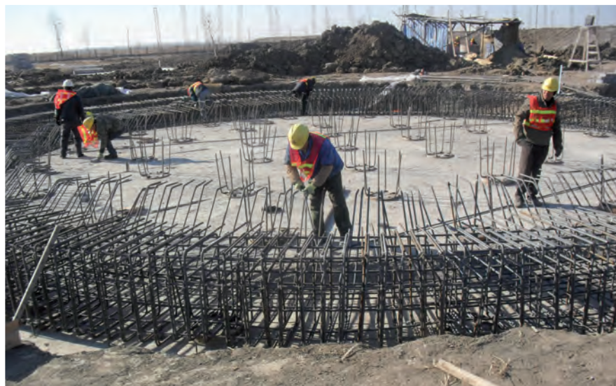
▲ Gründungsarbeiten für die neue Biogasanlage der Firma Fonterra
