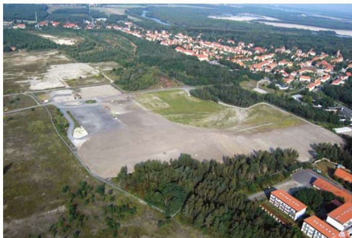
Erfolgreicher Abschluss der Sanierungsmaßnahmen
