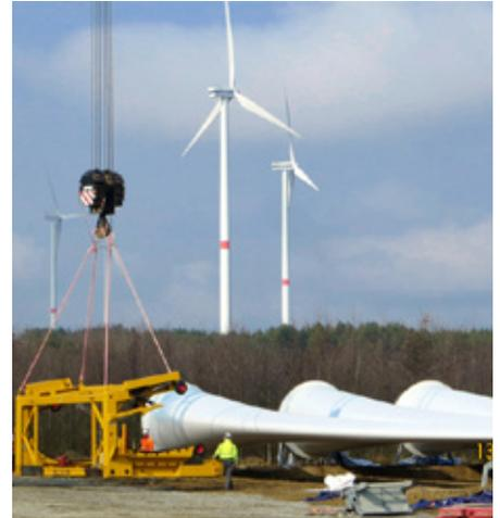
▲ „Flügelaufnehmer“ bei der Vorbereitung zur Montage des ersten Rotorblattes
