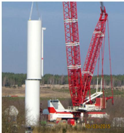
▲ Montage eines zweiten von insgesamt sechs Turmsegmenten
