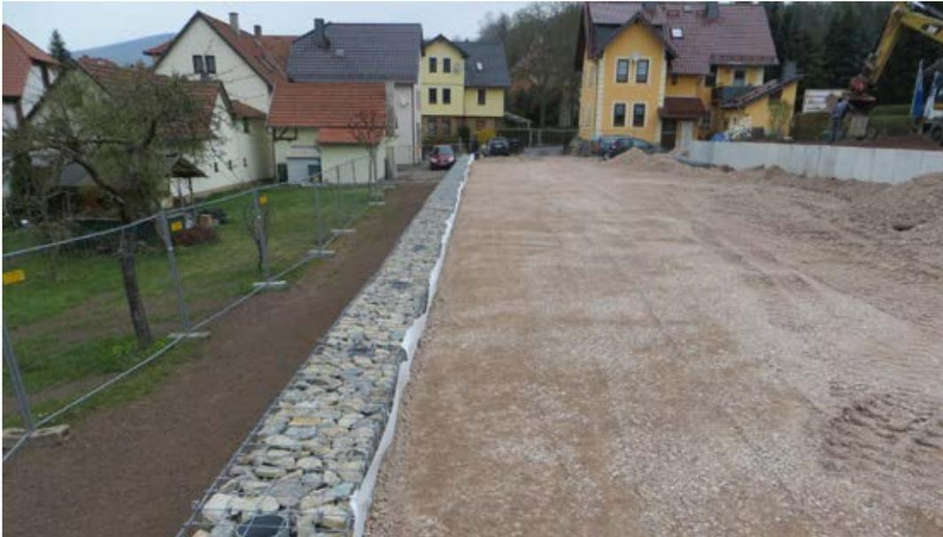
*Geländemodellierung mithilfe einer Gabionenmauer.*
