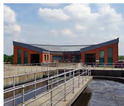
▲ Belebungsbecken mit Zentralhebewerk der Kläranlage Delitzsch (Pump- und Gebläsestation)
