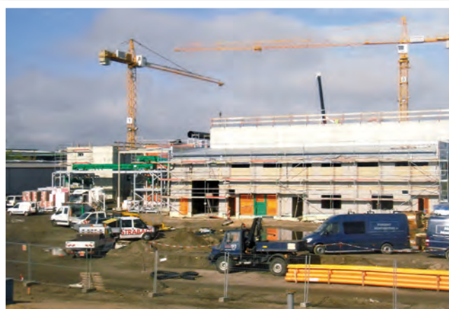
▲ Ansicht der Biogasanlage im Bau
