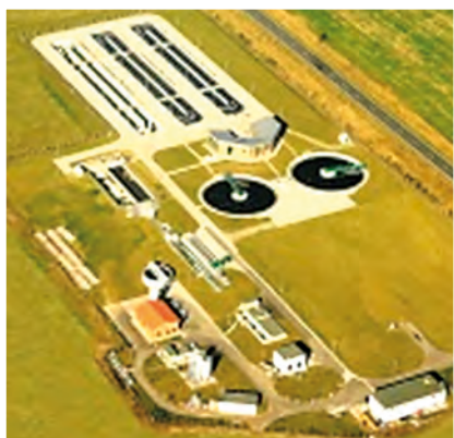
▲ Luftbild Kläranlage Delitzsch
