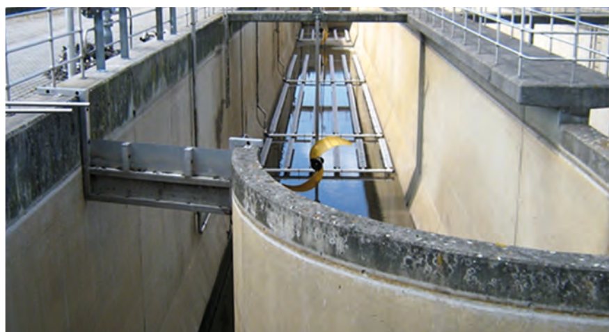
▲ Umbau der Belüftung der Belebungsbecken der Kläranlage Delitzsch
