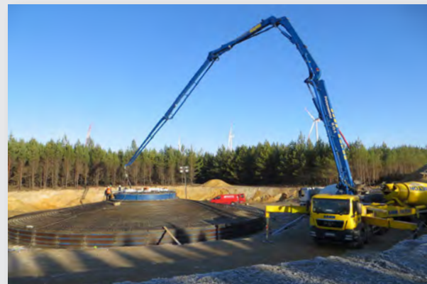
Fundamentbetonage auf einer Windparkbaustelle
