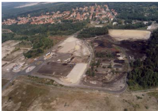
Umsetzung der Sanierungsmaßnahmen
