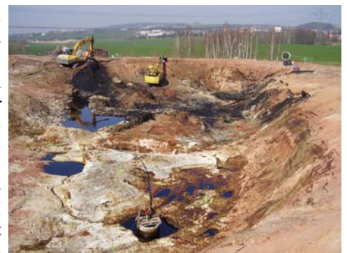
Entnahme der letzten Säureharze und Restberäumung der Teichsohle (April 2007)
