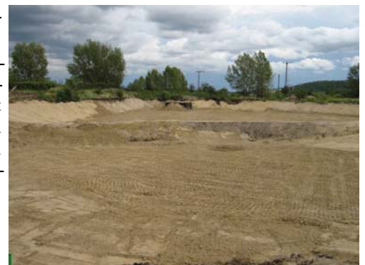
Fläche während der Verfüllung
