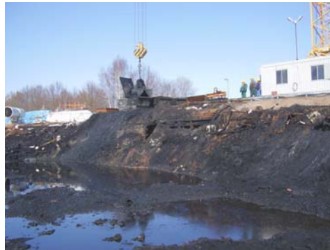
Entnahme Säureharz mit Turmdrehkran und Verladung in Deckelcontainer
