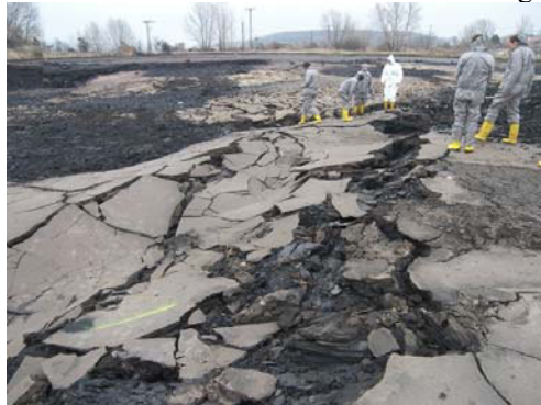
Festes Bitumen zu Sanierungsbeginn
