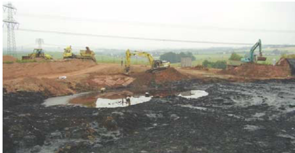
Südbecken: Abschälen Restsäureharz und Rückbau Süddamm
